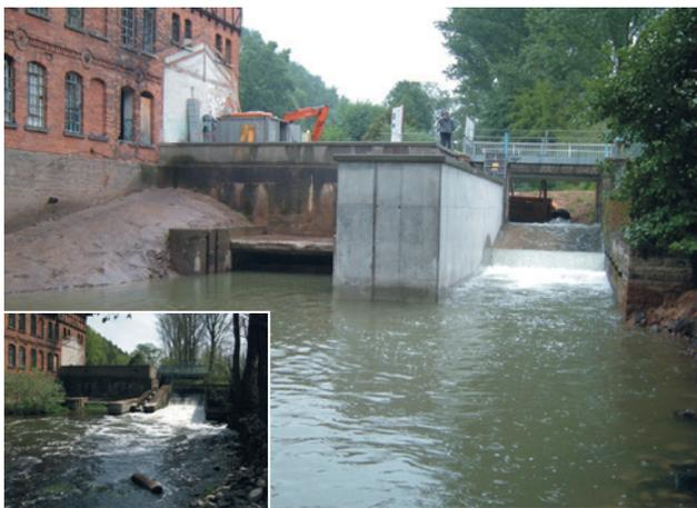
Die Fisch-Schleuse wurde an der Stelle des alten nicht funktionstüchtigen Beckenpasses (siehe kleines Bild) errichtet. In der Bildmitte (großes Bild) ist die Schleusenkammer zu erkennen, die Einschwimmöffnung liegt knapp unter Wasser.
