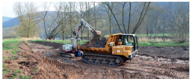
Die Werra wurde durch Geländeabtrag in der Aue aufgeweitet
