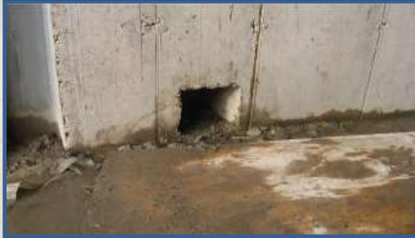
**Bypass für Abstieg ( $Q = 180 \text{ l/s}$ ) mündet in die FAA**
